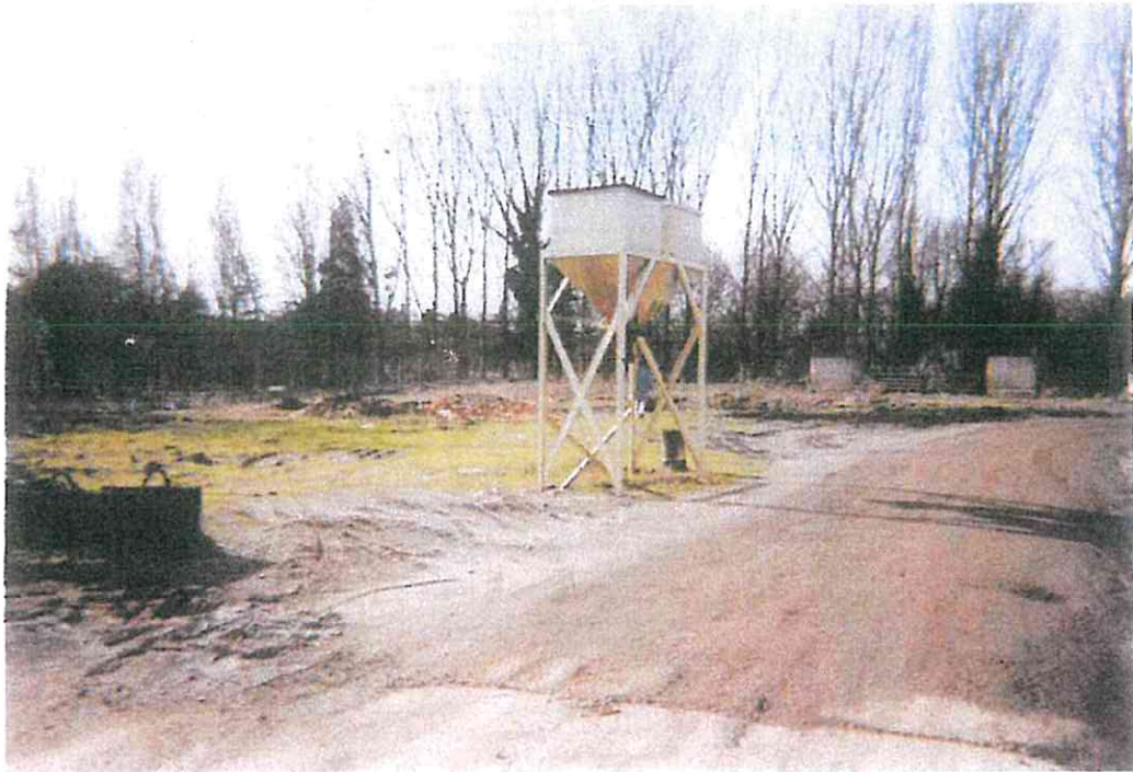
Photos 5 et 6 : Parties remblayées par les sables de fonderies du site A.P.M. Bléré-Laval site de Bléré
